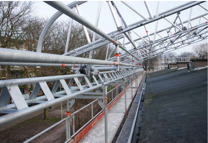
Doorkijk onder de kapconstructie.
