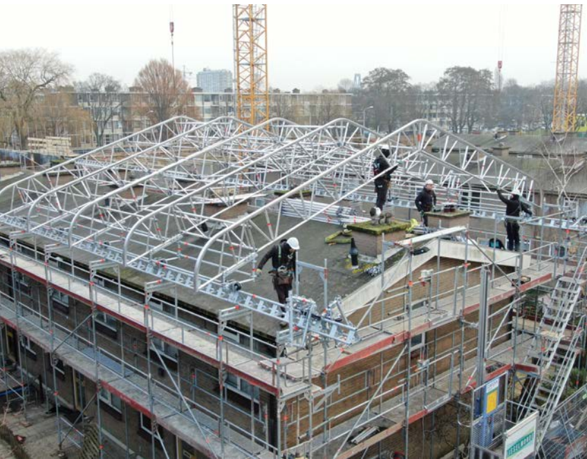
Montage van de dakkapconstructie.
