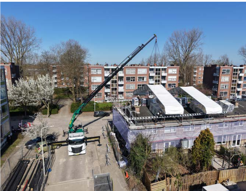
Plaatsing van de complete kapsecties.
