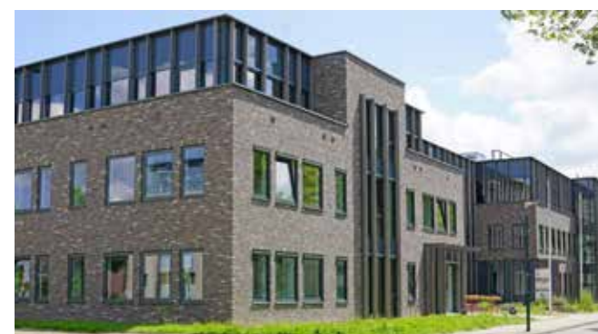
Totaaloverzicht van de gekoppelde kantoorpanden.
