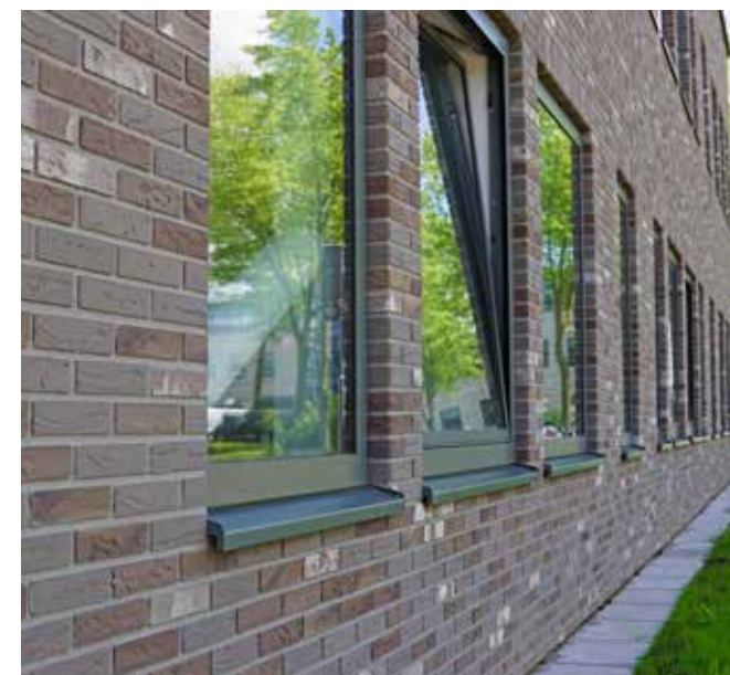
Kozijnaansluiting met gevelstrips.
