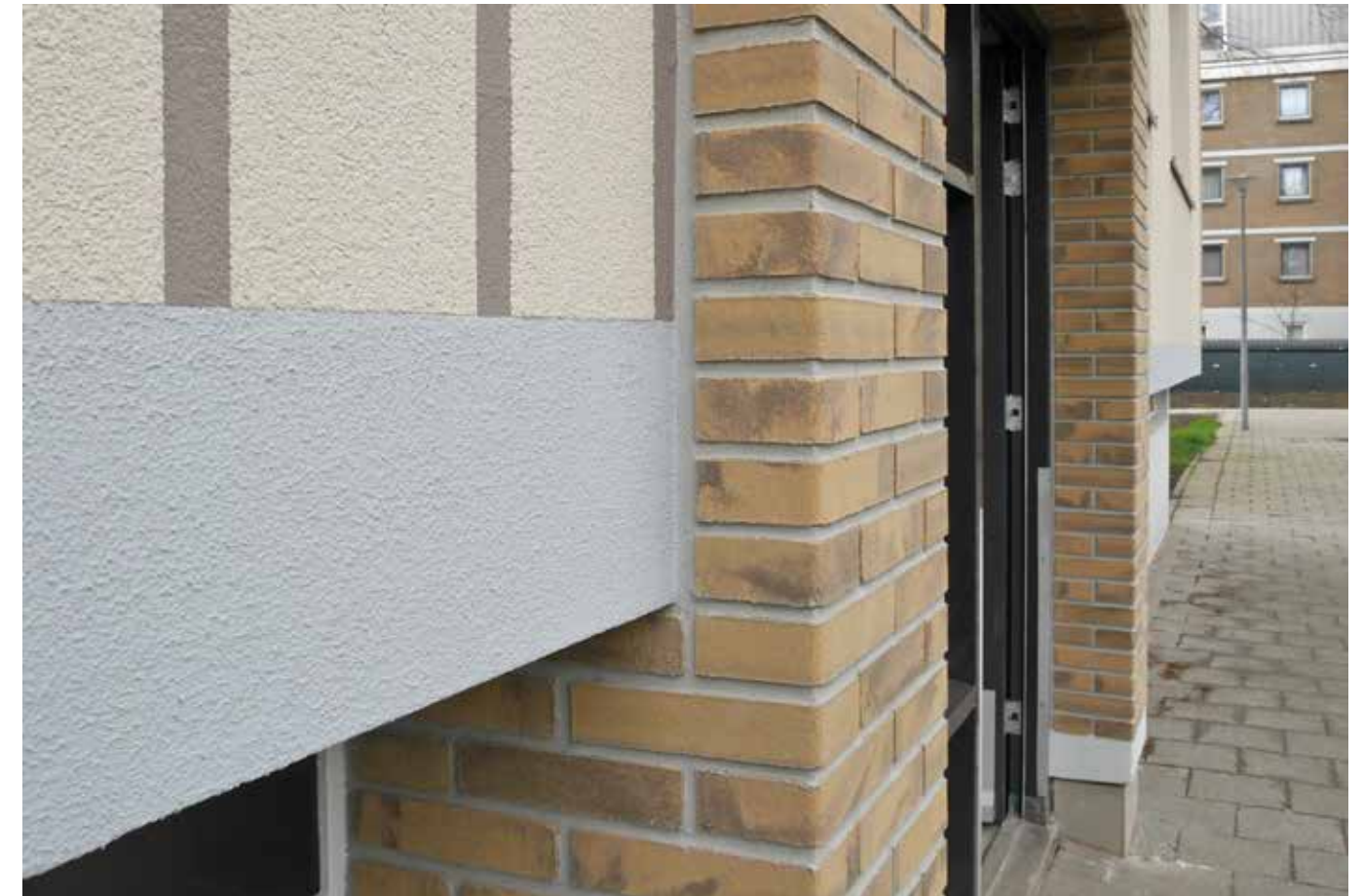
De vloerrand, belijningen en gevelstrips komen samen.
