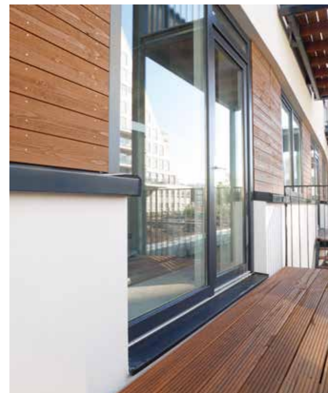
Achterzijde na transformatie.
