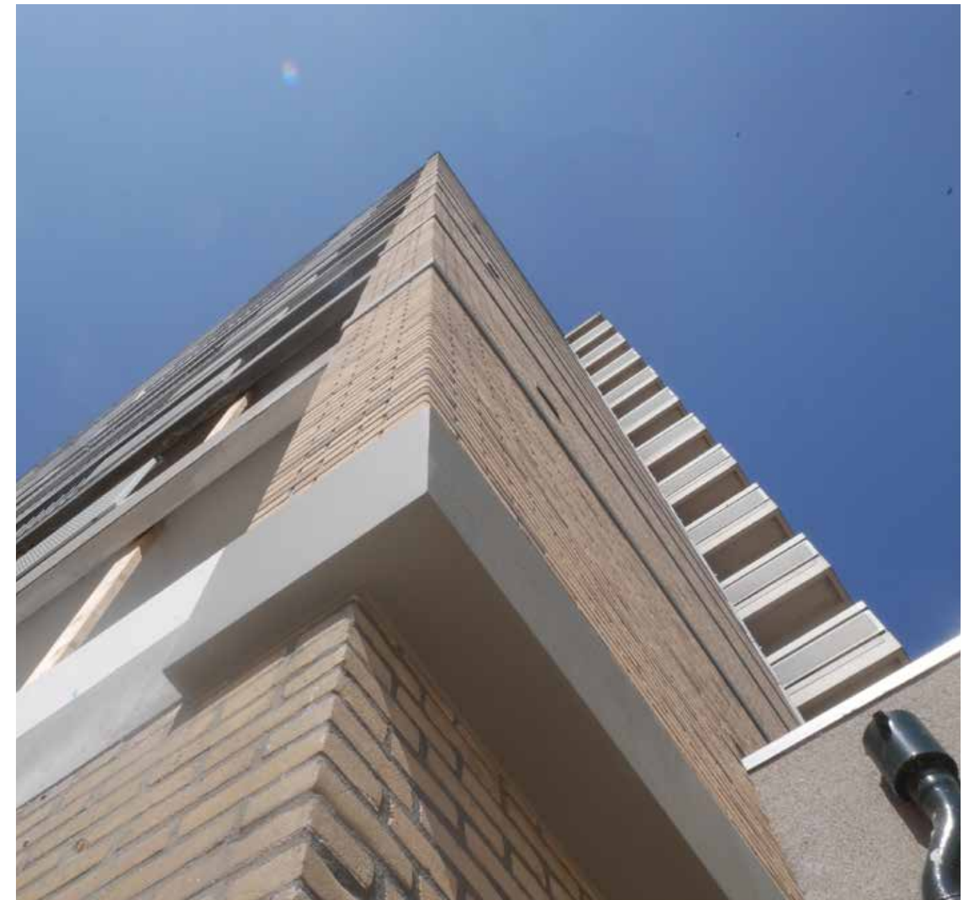
Kenmerkend aan de ERAflats zijn de horizontale, lichte banden in de kopgevels.
