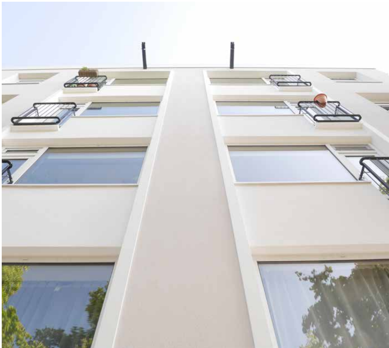
Het appartementencomplex op de hoek van de Rösener Manzstraat en Korfmakersstraat in Delfshaven is weer helemaal van deze tijd. Rondom de kozijnen zijn StoDeco-lijsten aangebracht, die de betonnen kaders van de oude gevel evenaren.
