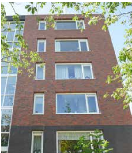
Voor de afwerking zijn twee kleuren gevelstrips geselecteerd: antraciet en een roodtint.
