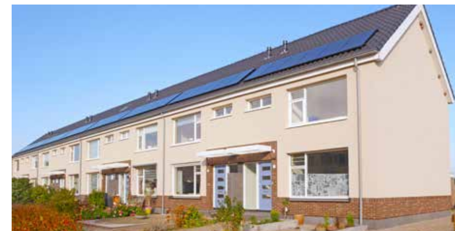
De plints van de woningen bestaan uit steenstrips.
