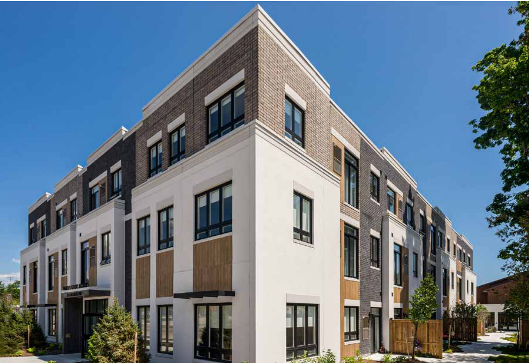
Gevelbekleding van het hoogste niveau in project Parkview.
