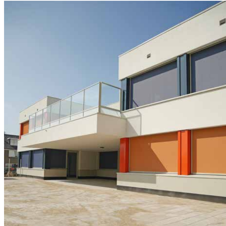
Kleur- en niveauverschillen in het nieuwbouwdeel.
