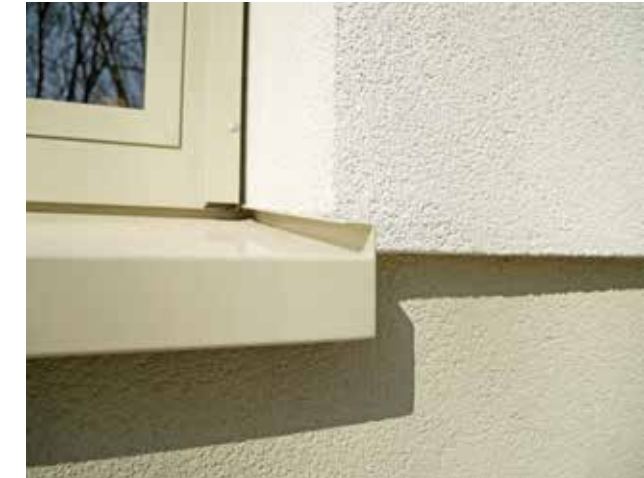
De aansluitdetails vergden een gedegen voorbereiding.
