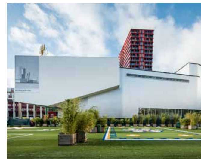
Door de witte sierpleister of pleisterwerk en de witte kunststof gevelbeplating is de gevel een stuk lichter en onderhoudsvriendelijker.
