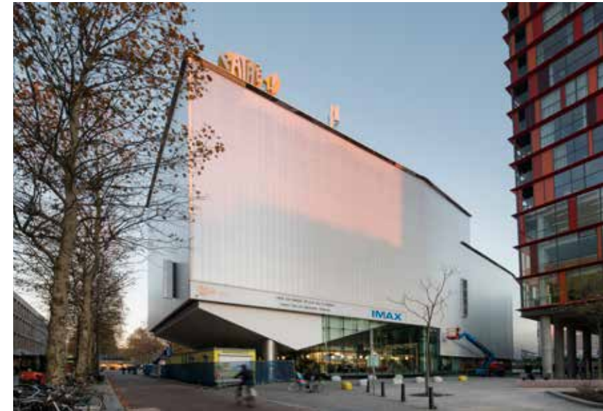
De gevelbeplating is verticaal gemonteerd.
