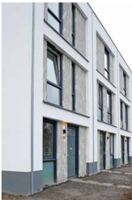
De gevel is afgewerkt met stucwerk, de accentvlakken met steenstrips.
